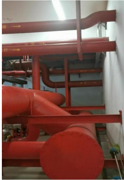
消防泵房管道布置现状图
